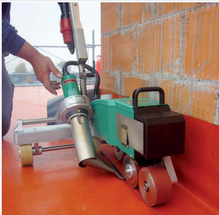
Sa construction étroite permet le soudage jusqu'à une distance au mur de 110 mm.
