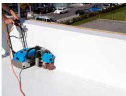
5. Soudez les joints à l'air chaud
